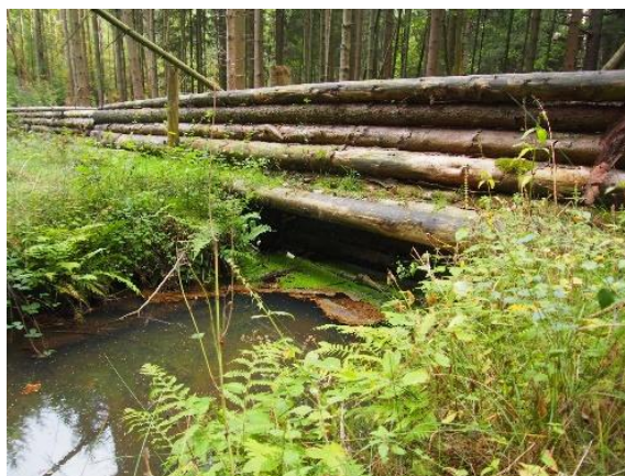
Figura 6 - Baraj permeabil din bușteni în pădurea de deasupra orașului Pickering, Anglia. (Fotografie: Klára Kerpely, WWF HU)
