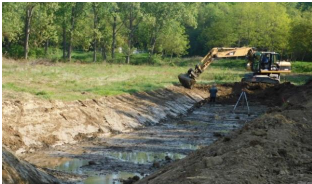
Figura 26 - Lucrări de construcție în Püspökszilágy. (Fotografie: Municipality din Püspökszilágy)
