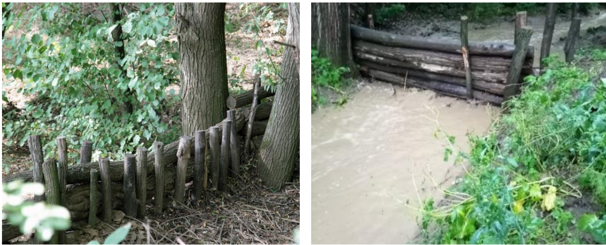
Figura 28 - Baraje din bușteni în sezonul uscat și „la muncă” în Püspökszilágy. (Fotografie: Ministerul de Interne, Municipality din Püspökszilágy)
