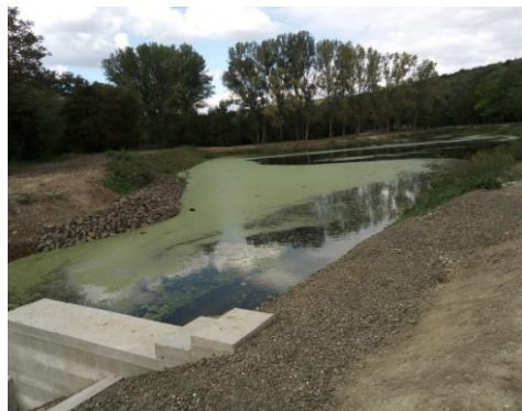
Figura 27 - Lucrări de construcție în Püspökszilágy. (Fotografie: Municipality din Püspökszilágy)
