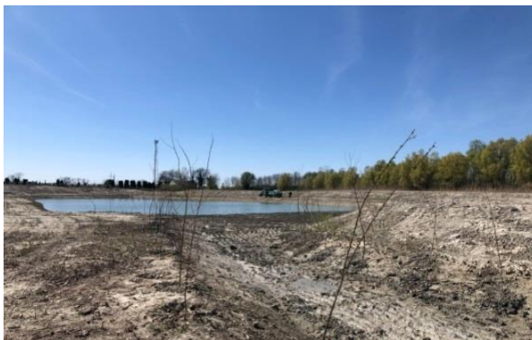
Figura 19 - Lucrări de terasament în Bătya. (Fotografie: Zsófia Szabó, Bătya)
