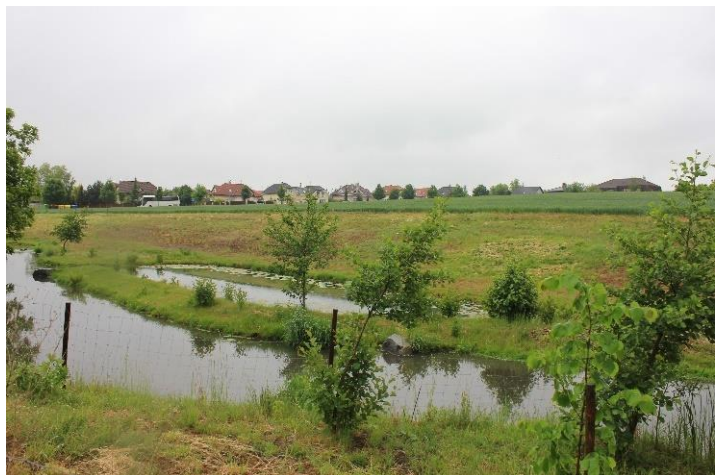
Figura 2 - În Hostovice, Republica Cehă, riscul de inundații a fost redus prin refacerea meandrelor unei secțiuni de pârâu interior și aplatizarea zonei sale inundabile, creându-se un parc atractiv pe locul unui fost canal. (Fotografie: Viktor Mátyás Farkas, WWF HU)
