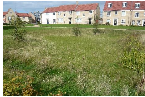
Figura 11 - Bazin de stocare a apelor pluviale, potrivit pentru inundare temporară, care funcționează și ca zonă verde. (Forrás: susdrain.org)
