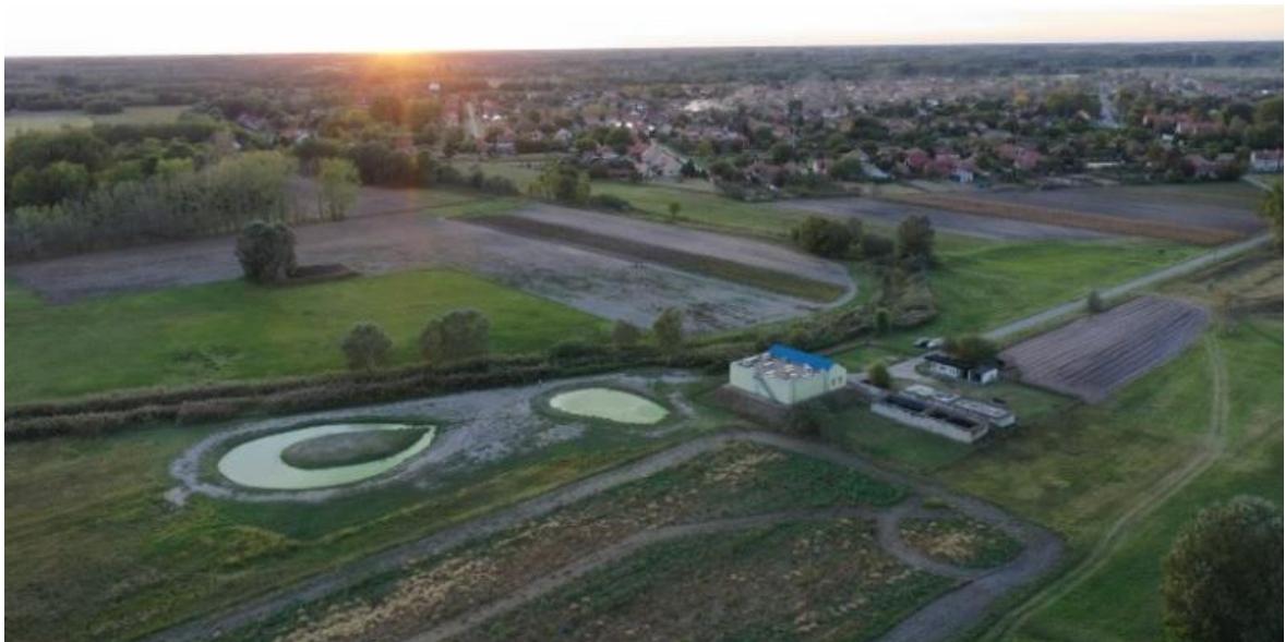
Figura 36 - O vedere de ansamblu a soluției de retenție a apei din extravilan. (Fotografie: Filmever Stúdió)
